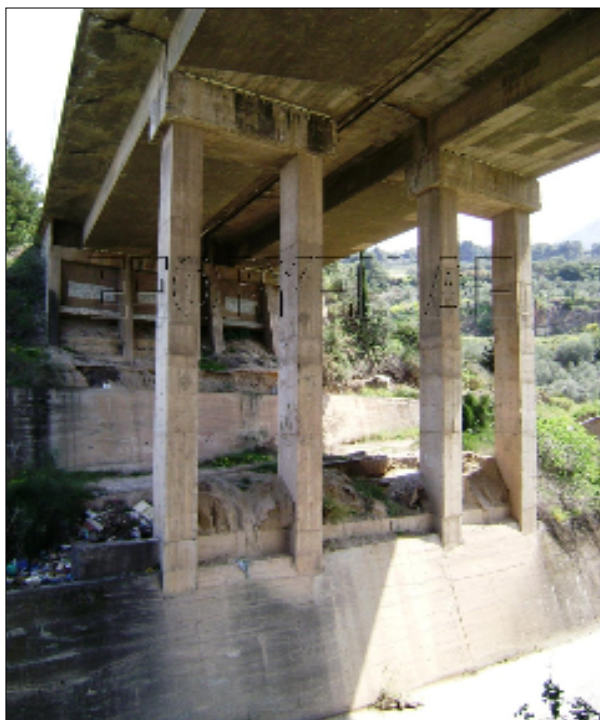
Ανατολικά μεσόβαθρα των 2 κλάδων της Γέφυρας
