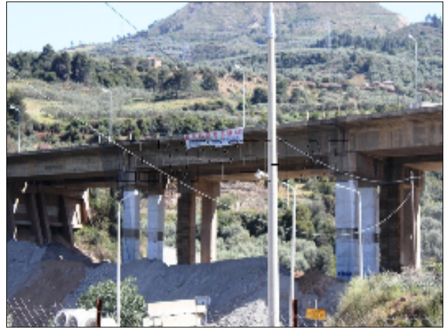
Η Γέφυρα λίγο πριν την κατεδάφιση
