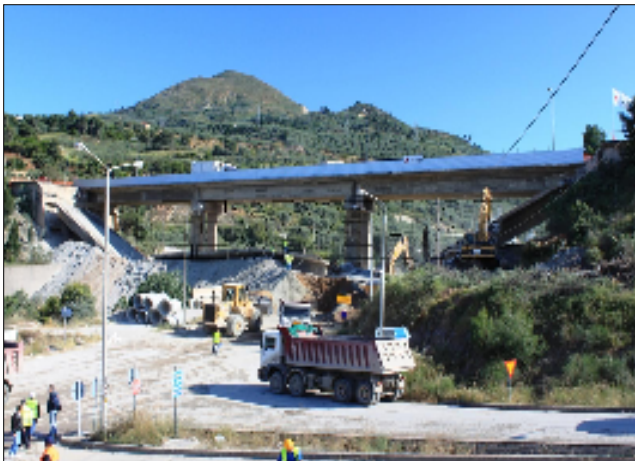
Κατεδάφιση της Γέφυρας
