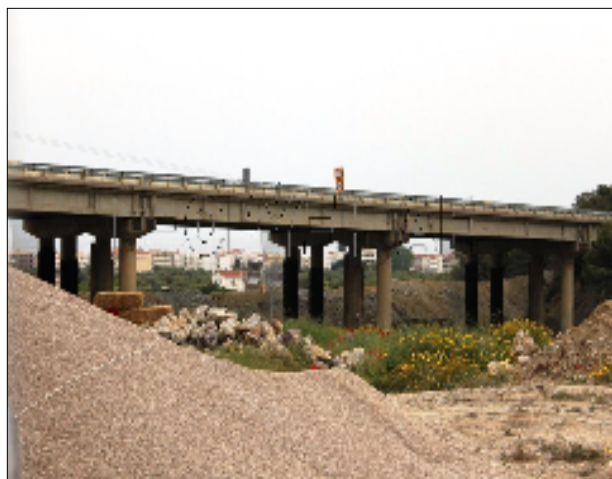
Η γέφυρα λίγο πριν την κατεδάφιση
