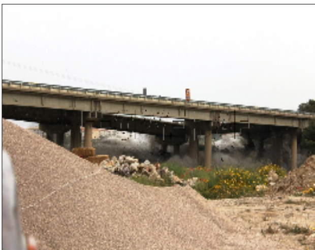
Κατεδάφιση της Γέφυρας
