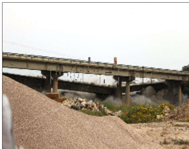
Κατεδάφιση της Γέφυρας
