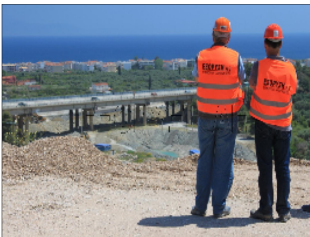
Τανοραμική άποψη της δίδυμης γέφυρας (Νότια πλευρά) και της ευρύτερης περιοχής
