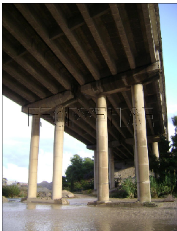
Ανατολικά μεσόβαθρα των 2 κλάδων της Γέφυρας
