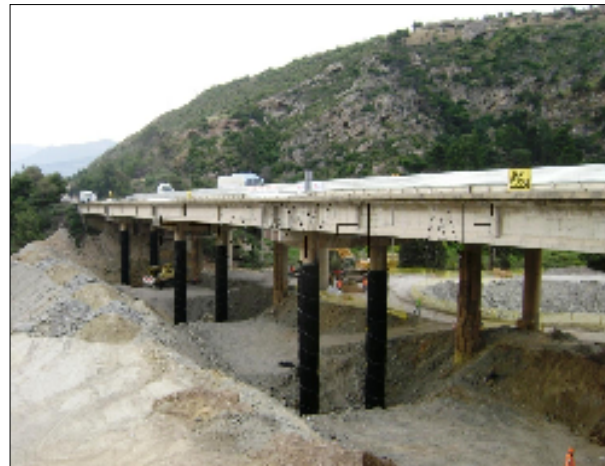
Βόρεια όψη – Δεξιός κλάδος, λίγο πριν την κατεδάφιση
